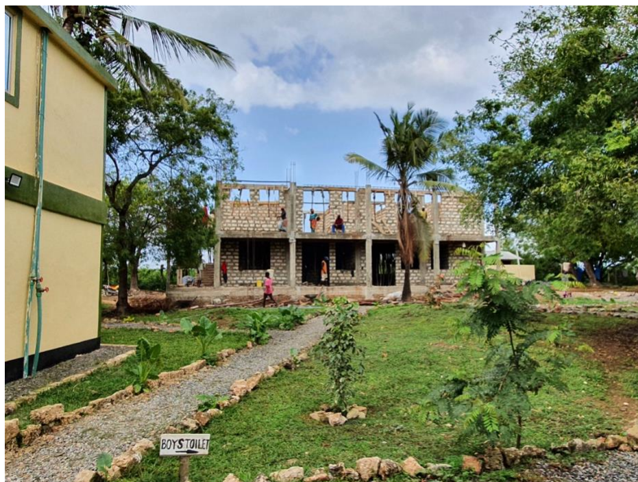
Der Rohbau der Krankenstation der Green Olive Schule/Internat (Mai 2021)
